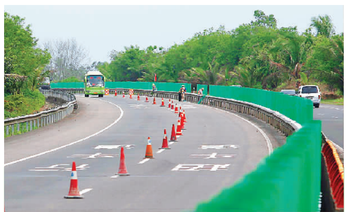
3月23日, 东线高速公路黄竹至琼海路段, 工人们正在加紧安装道路中间的挡光板, 以确保博鳌亚洲论坛年会期间道路安全畅通。东线高速左幅海口至琼海段自去年12月20日起大修, 对总长100公里的路段分期分批改造。 本报记者 王凯 摄
