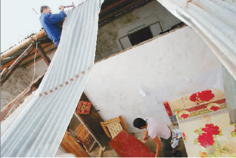
4月19日,文昌市龙楼镇灾民林道英及家人正在修补被“浣熊”掀掉的屋顶。 本报记者 张杰 摄
