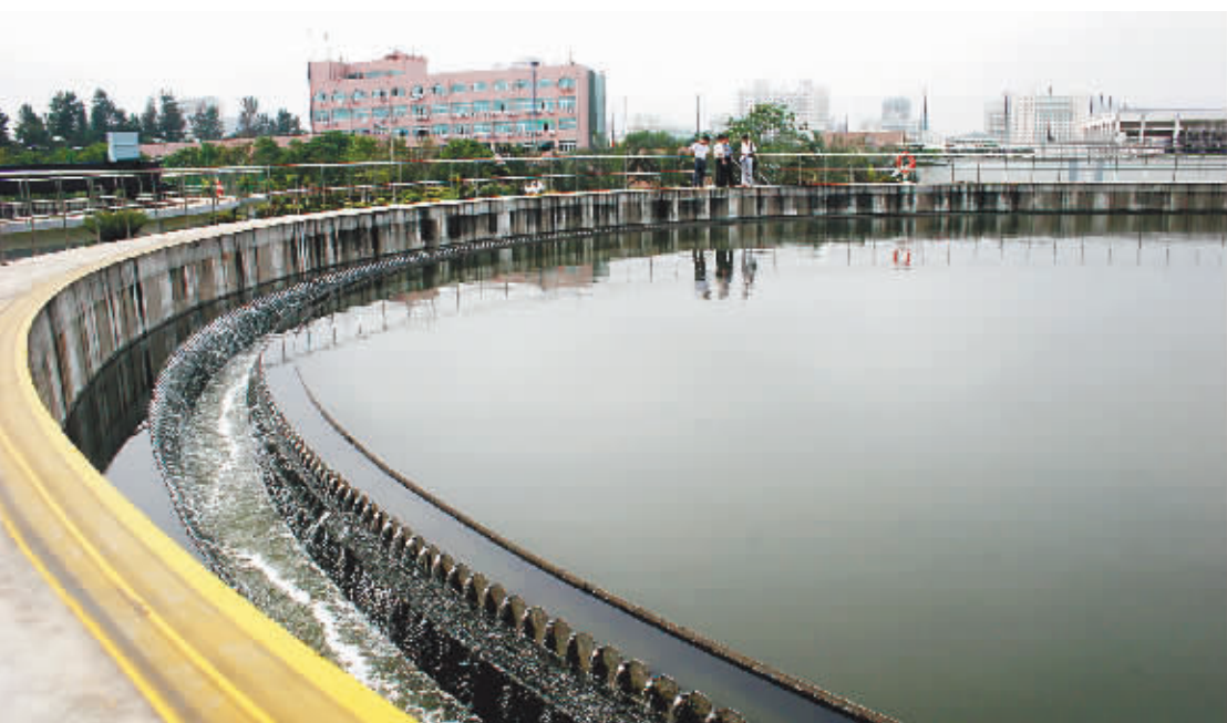
海口市污水处理厂沉淀池。本报记者 苏晓杰 摄
