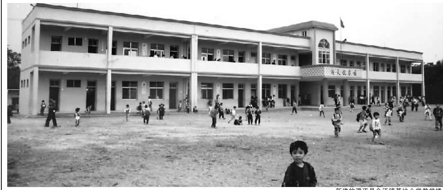
新建的澄迈县金江镇基地小学教学楼
