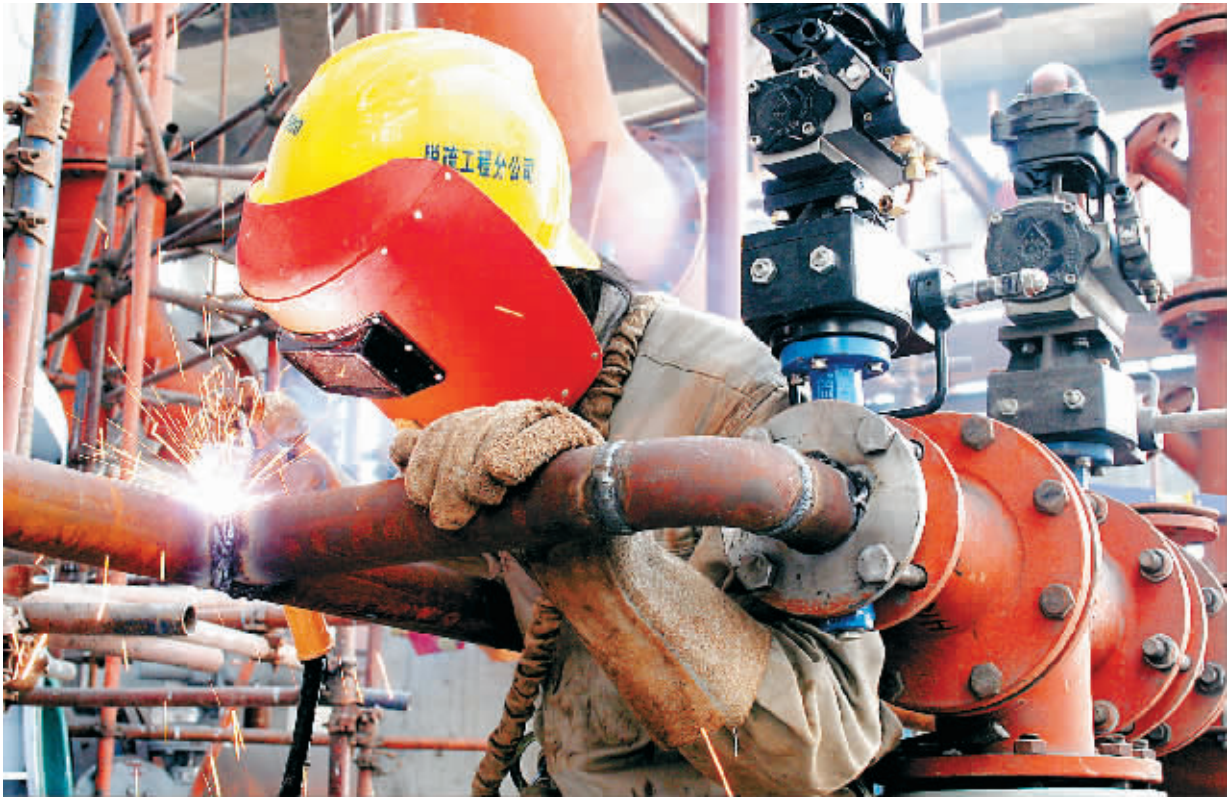
华能海口电厂节能减排不含糊。图为一名电焊工人焊接石膏排泵管道作业。本报记者 苏晓杰 通讯员 卢胜 摄
