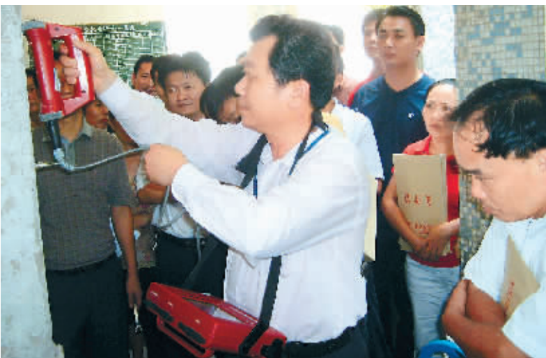
6月14日在海口市琼山三小,技术专家正在指导有关人员如何通过先进仪器检测墙体结构。本报记者 张中宝 摄
