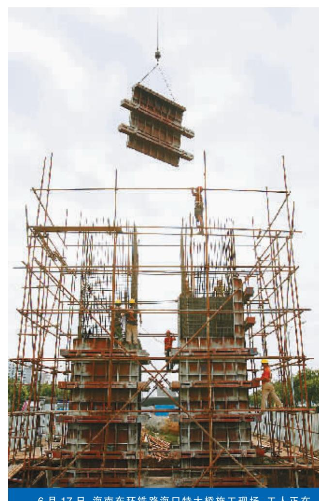
6月17日,海南东环铁路海口特大桥施工现场,工人正在安装桥墩模板。本报记者 宋国强 摄
