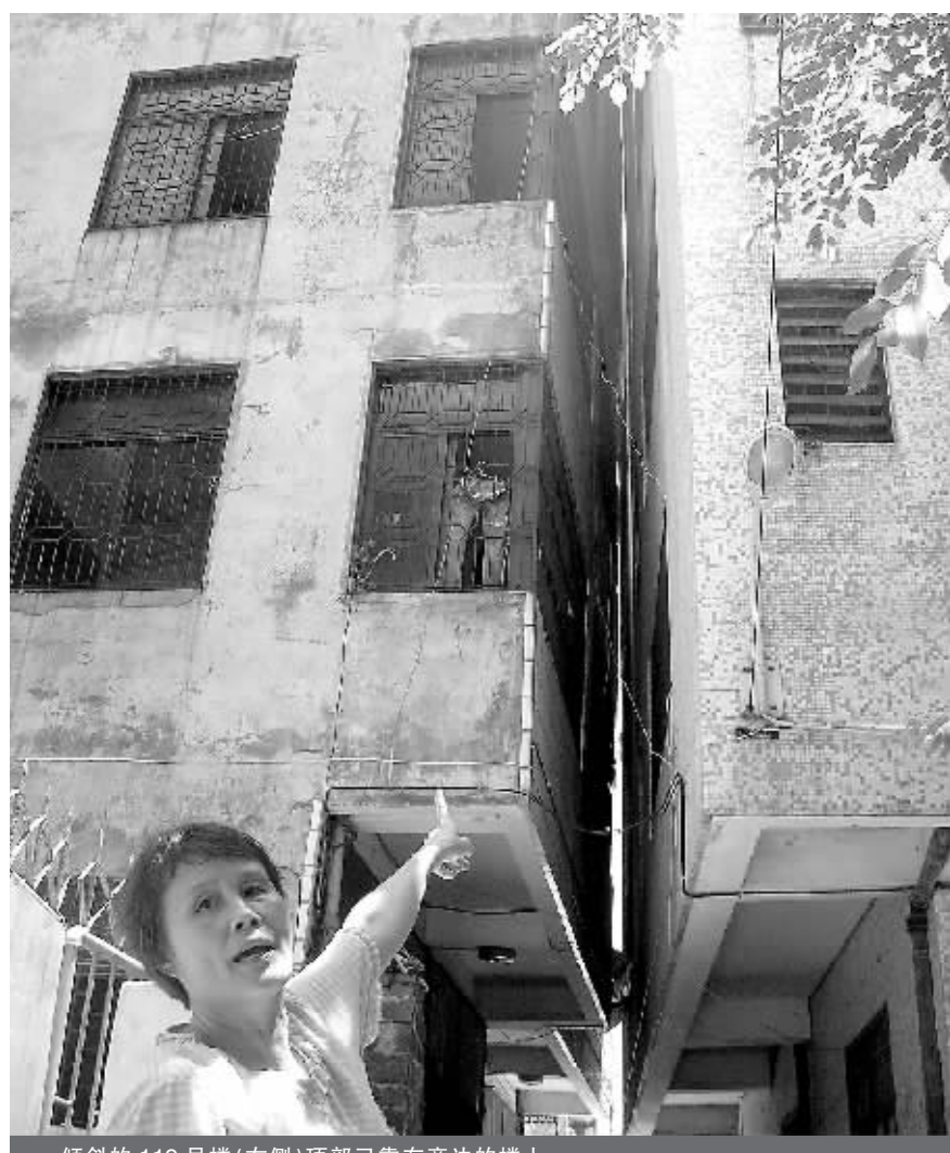
倾斜的119号楼(右侧)顶部已靠在旁边的楼上。 本报记者 林伟 摄
