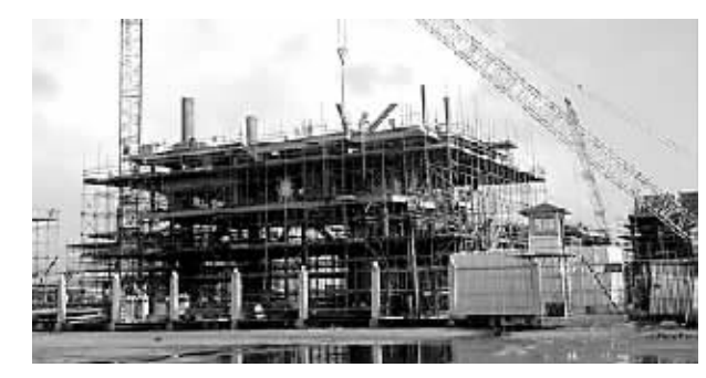
文昌油田群上部组块建造项目吊装场景。刘培强 摄
