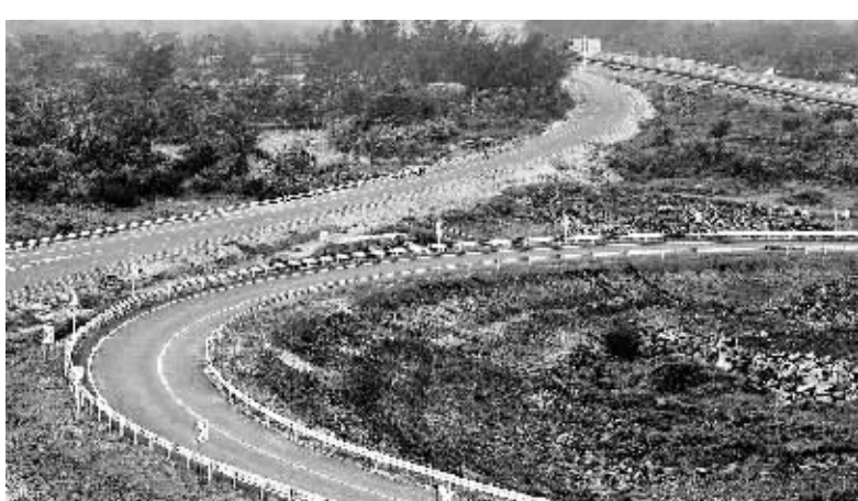
海口绕城公路东线高速立交段匝道。
