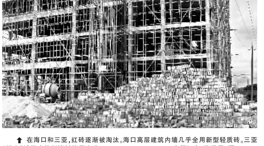
↑在海口和三亚，红砖逐渐被淘汰。海口高层建筑内墙几乎全用新型轻质砖。三亚“禁实”城区建筑新墙材使用率达90%。
