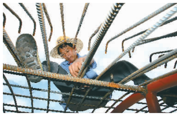
中铁四局东环铁路琼海制梁场内,工人正在绑扎箱梁钢筋。
