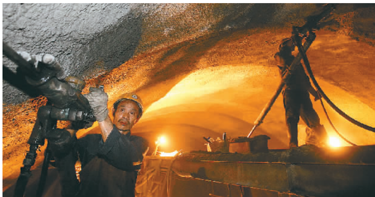
9月16日,四标段重点控制工程之一、位于三亚市田独镇内的芭蕉岭隧道270米处,工人手持风转机在打炮眼。
