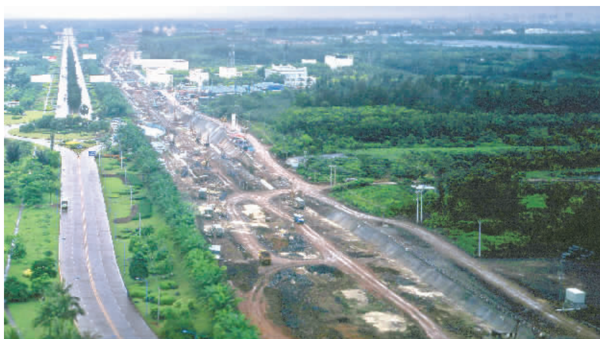
9月20日,海口美兰机场相邻的东环铁路美兰机场隧道施工现场。美兰隧道是全线重点控制工程,实验段成功建成后,目前已全面开挖。该隧道是目前国内最长的明挖隧道。车站将设在机场地下,乘客可以坐列车往返美兰机场,下轻轨后可上飞机。
