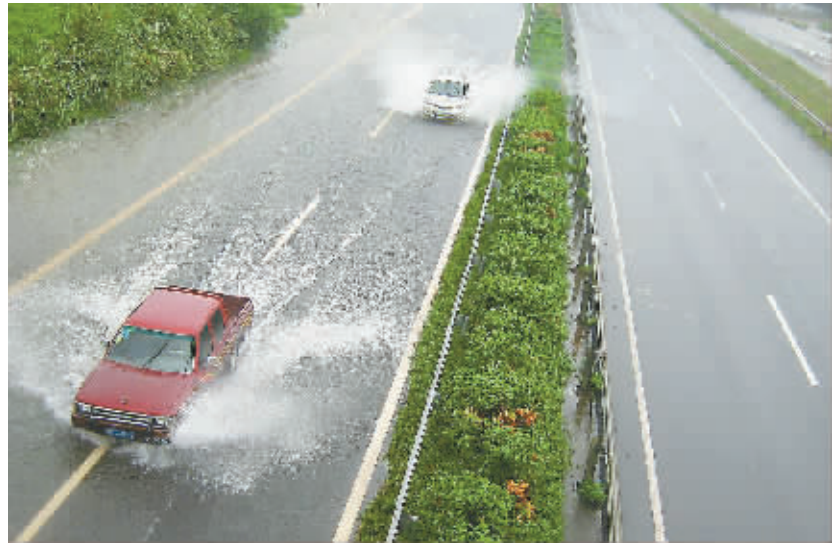
14日中午,东线高速公路与绕城高速公路相交的互通立交桥上积水严重。本报记者 侯小健 摄
