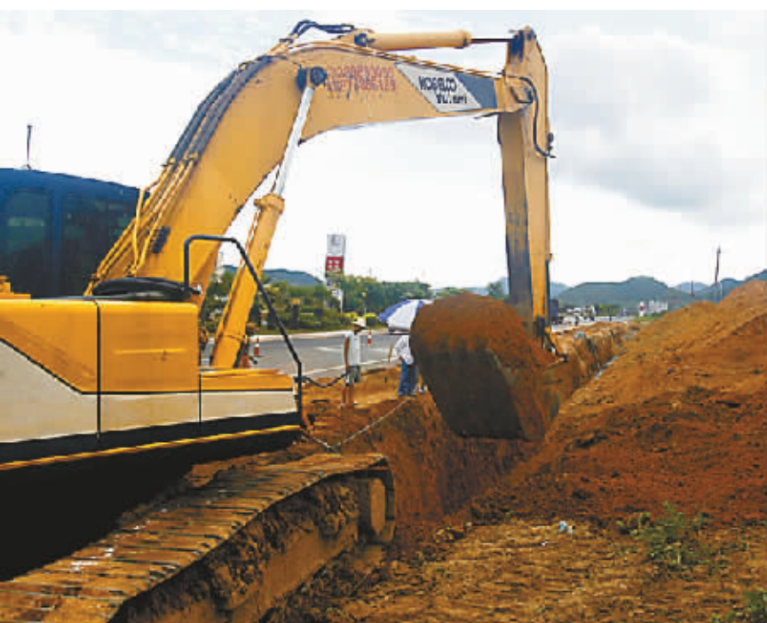
吉阳大道施工现场。 本报记者 程范淦 摄
