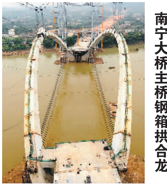
南宁大桥主桥钢箱拱合龙
