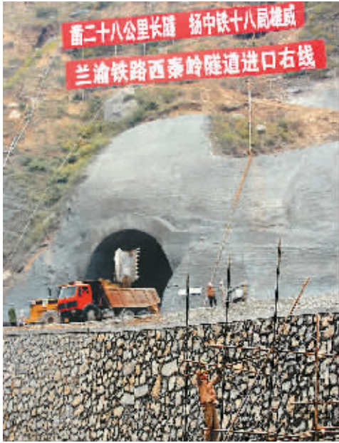
兰渝铁路西秦岭隧道进口右线
