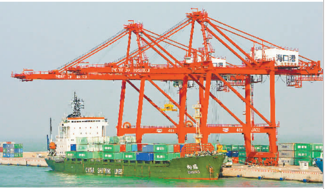
日前，在海口港二期深水泊位，工作人员操作门吊向“向瑞”号货轮卸下集装箱。
