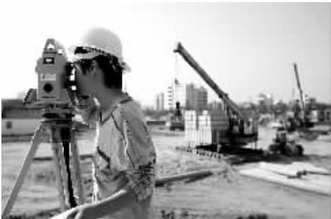
2月12日上午，在海口市海甸溪北岸回迁区的水岸阳光A安置小区建设工地，测量员正在测试地基打桩点的位置。这里将建起3栋25层及5栋27层的安置房，总建筑面积达到139426.63平方米，工程造价34011万元。届时，海甸溪改造项目中的搬迁居民将迁入此处的新居。 本报记者 张杰 摄
