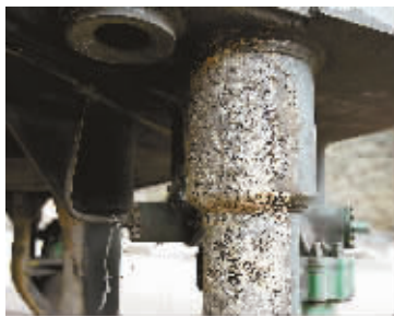
西昌卫星发射中心3号塔架底部,留有火箭发射时烧灼的痕迹。
