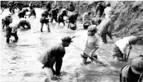
西昌卫星发射中心建设初期,建设者冒着严寒挖掘长征桥桥基。 海南日报记者 林萌 翻拍
