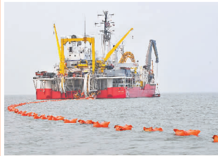
电缆敷设船在广东徐闻海面上向海南林诗岛移动，同时释放出电缆。
