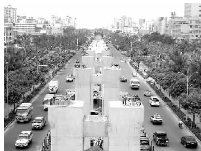
东环铁路海口特大桥工程进展顺利,一座座墩柱拔地而起,一字排开,蔚为壮观。本报记者 侯小健 摄
