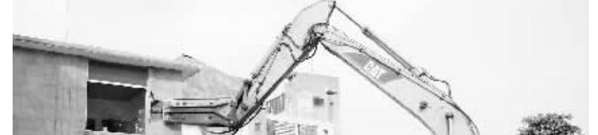
3月20日,海口市对滨江西路一处违法建筑进行拆除。 通讯员 骆陈坦 摄
