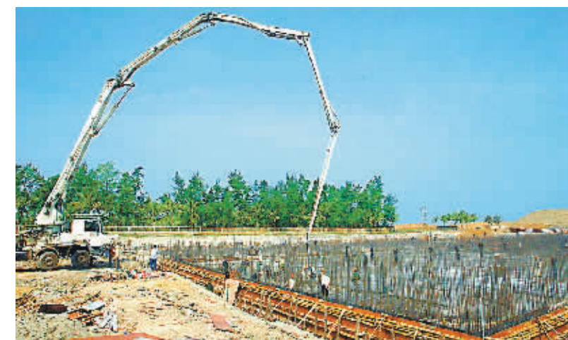
海口白沙门污水处理厂二期工地施工现场。本报记者 古月 摄
