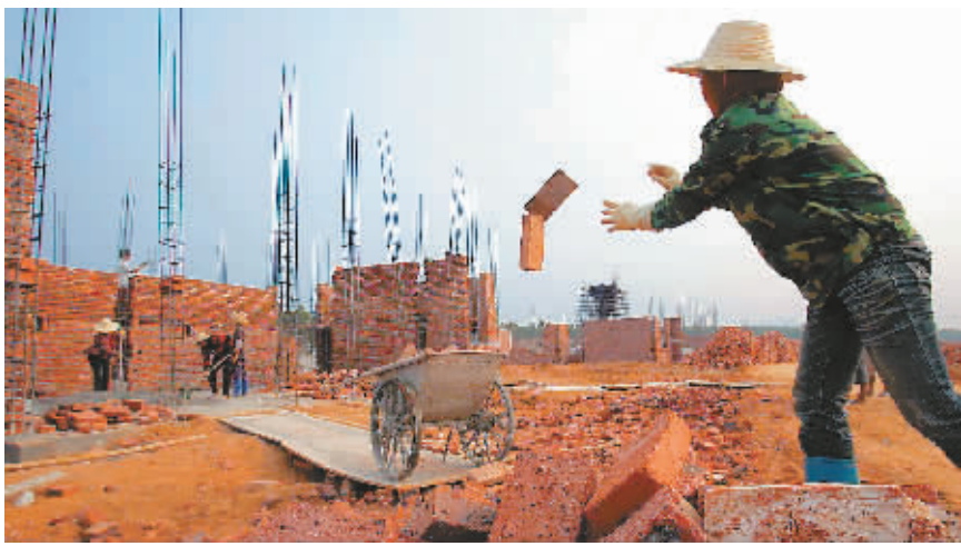
4月21日,在昌江海尾镇塘兴新村,工人正在忙着建设安置村民的永久性住房。 本报记者 张杰 特约记者 曾高文 摄
