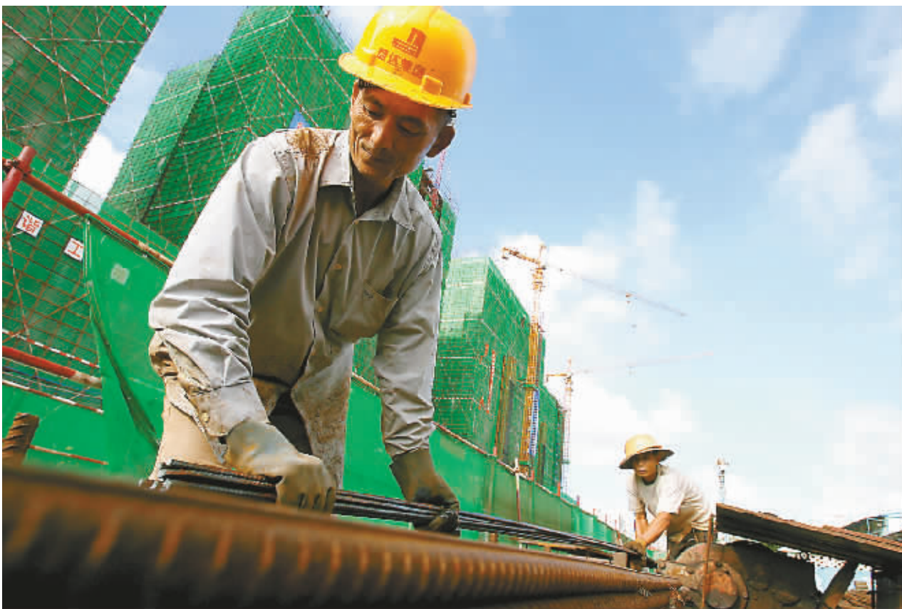
5月24日,工人在海口金玉广场工地切割钢筋。
