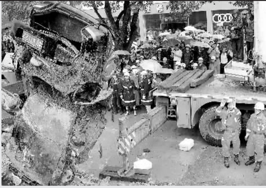
5月18日,一辆被塌桥压跨的轿车被吊出来。 通讯员 廖玉荣 摄
