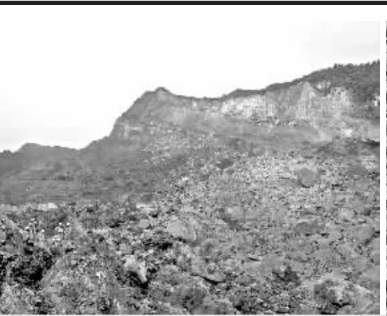
6月6日上午拍摄的山体垮塌现场。武隆山体垮塌现场的各项抢险救援工作正在有序进行。
