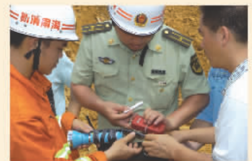
●为救援人员将安装好的两部伸缩式电话机放入隧道内
