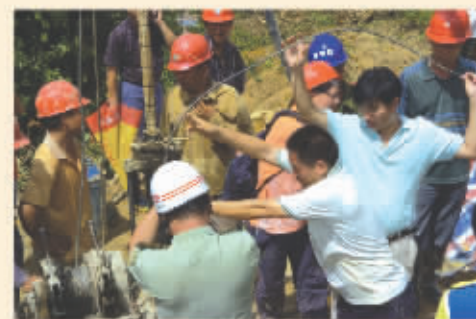
●为救援被困人员，二线技术人员布放电话机和通信电缆
