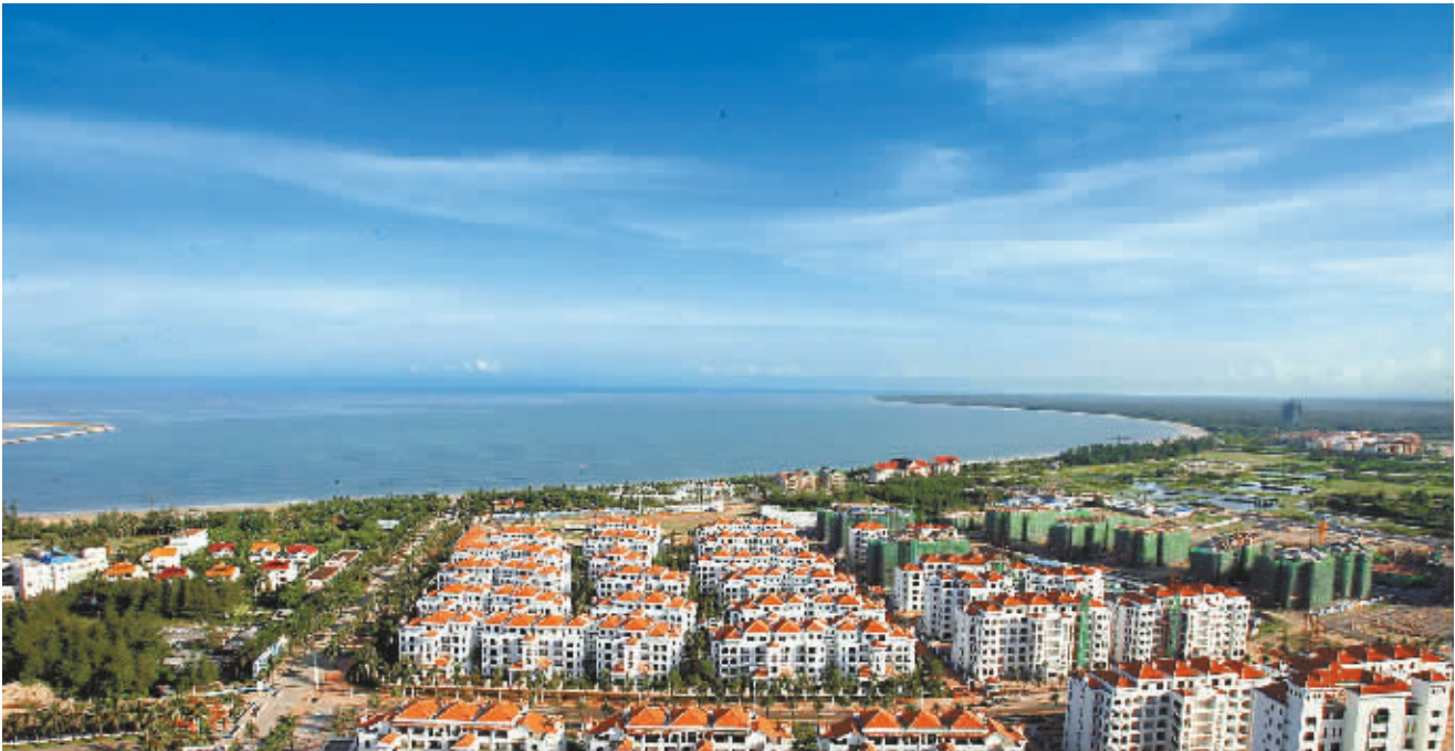
文昌高隆湾开发区的建筑群拔地而起。 本报记者 陈德雄 摄
