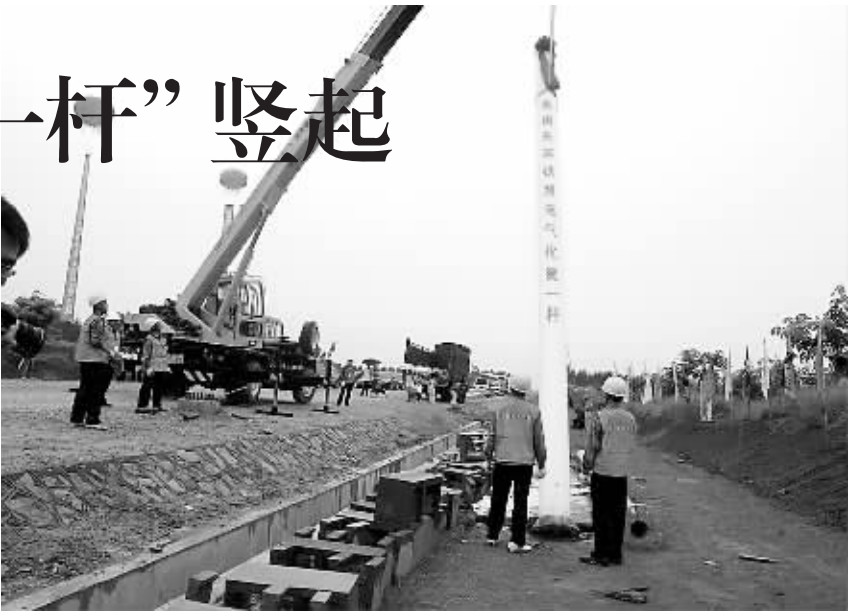
8月6日上午10时许,中铁电气化局集团二公司海南项目部施工人员拧紧最后一颗螺丝,海南第一根电气化铁路接触网杆耸立在东环铁路文昌至琼海区间。本报记者 洪宝光 摄
