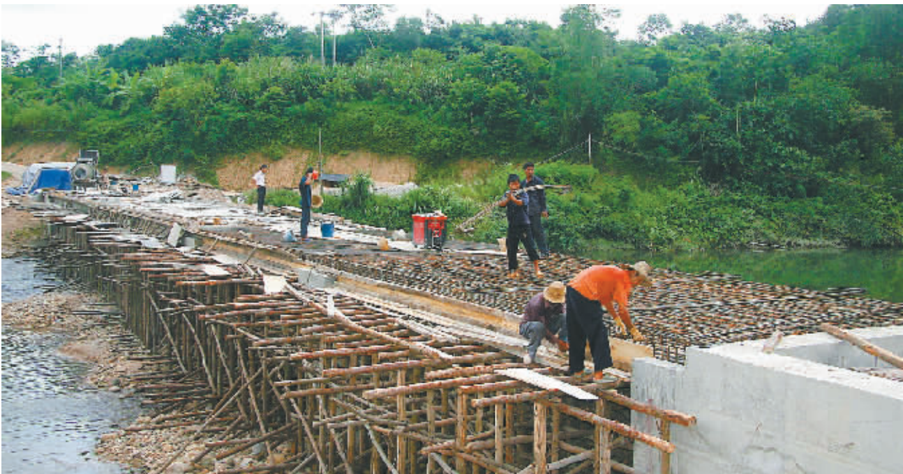
图为工人们正在细心加固桥梁钢筋，为梁桥浇筑做准备。 特约记者 黎大辉 摄
