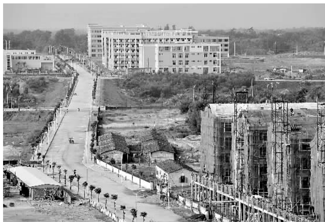
近年来,定安县按照“七通一平”要求,投入3亿元完善塔岭新区基础设施。新建道路10公里、排污管网20公里、供水管网18公里。图为定城镇塔岭新区内一栋栋拔地而起的楼盘和厂房。 本报记者 王凯 摄
