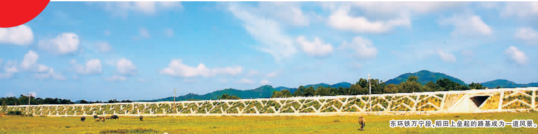
↑气势如虹的东环铁海口双线特大桥，目前已完成全部621座桥墩建设，铺架工作正在以每天百米速度向前推进。该桥全长21.37公里，为全线最长桥梁。
