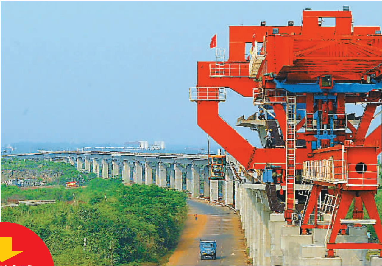
↑气势如虹的东环铁海口双线特大桥，目前已完成全部621座桥墩建设，铺架工作正在以每天百米速度向前推进。该桥全长21.37公里，为全线最长桥梁。
