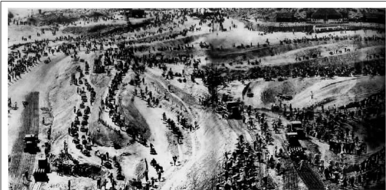
1958年,松涛大坝总攻“170”工程施工现场。
