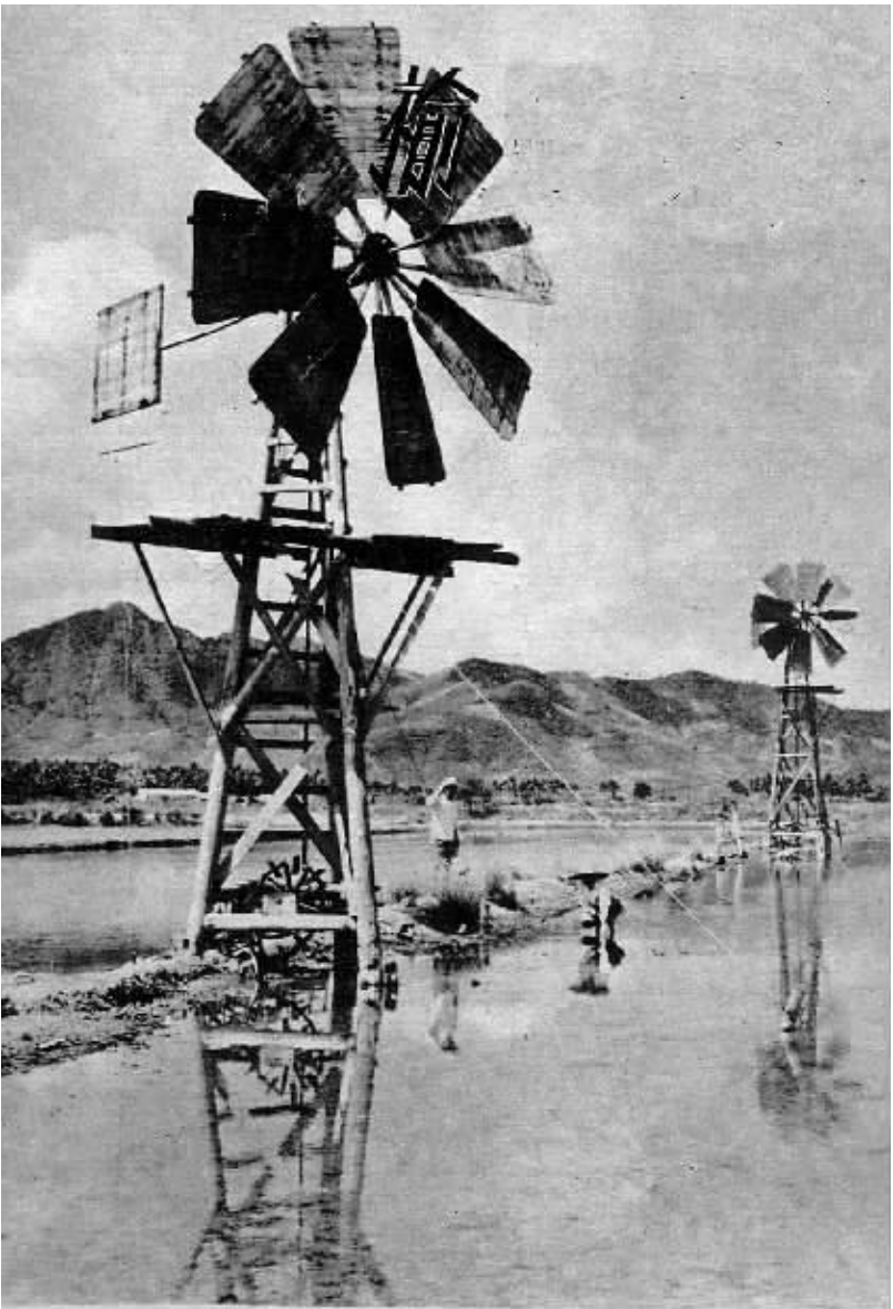
1958 年初，榆亚盐场用于生产的自动转向风车试验成功，盐场装上的 21 部风车代替了过去的人力水车。 陈福北 摄
