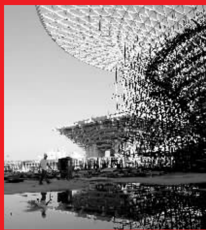
上海世博园区与中国馆遥相呼应的世博轴建设工地(2009年6月25日摄)。
