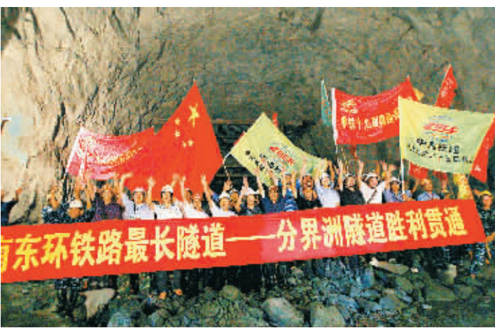
10月9日,中铁19局、25局工程技术人员会师海南东环铁路最长暗挖隧道——分界洲隧道,标志着这一全长3750米,最大埋深360米的隧道贯通。分界洲隧道位于万宁与陵水之间,于2008年2月9日正式进洞施工。本报记者 单憬岗/文 本报记者 古月 通讯员 叶坚/图
