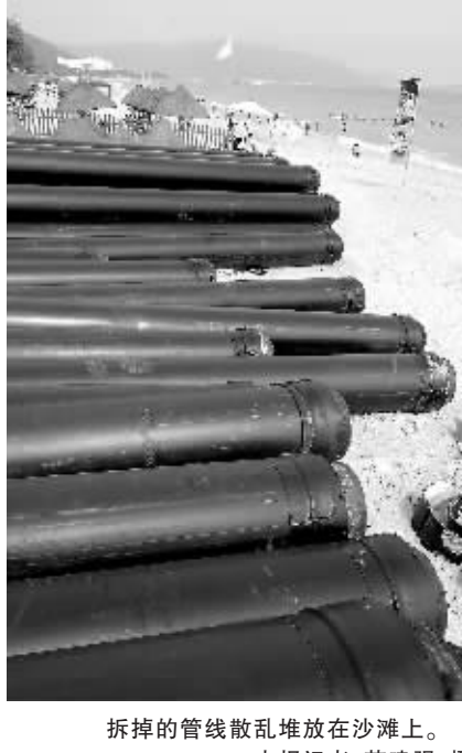
拆掉的管线散乱堆放在沙滩上。 本报记者 苏建强 摄
