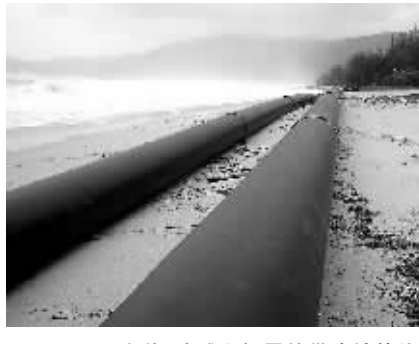
国庆节,沙滩上裸露的供冷铁管。
