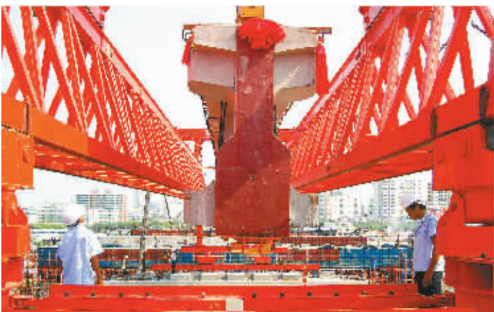
海南东环铁路海口东站站前广场工程已完工,海口东站站前广场工程已完工,海口东站站前广场工程已完工。
