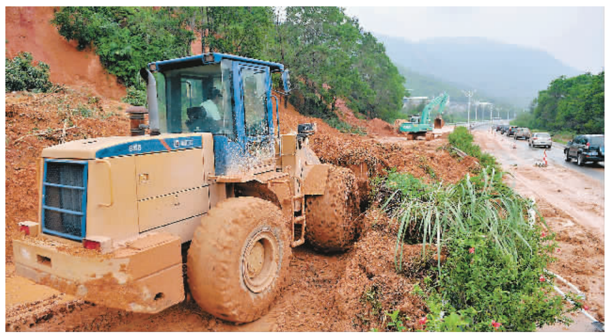
昨天,路政工人正在东线高速公路滑坡现场进行道路抢修。本报记者王凯摄
