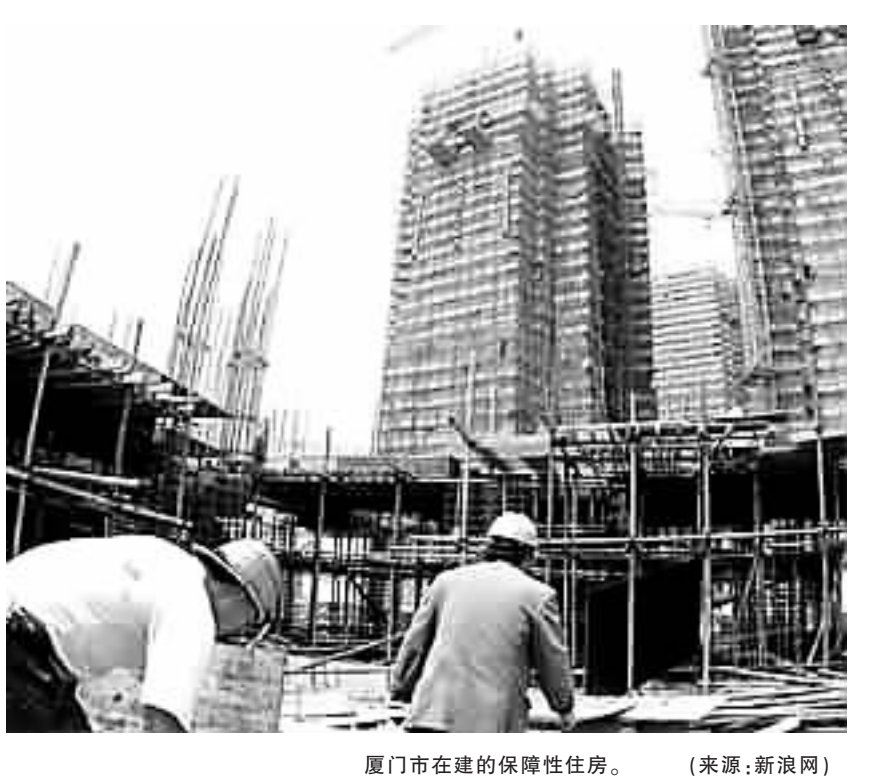
厦门市在建的保障性住房。(来源:新浪网)
