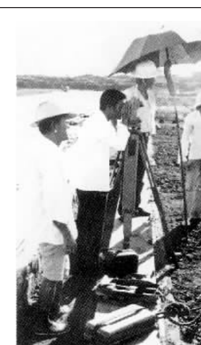
洋浦港工程技术人员顶着烈日进行作业。
