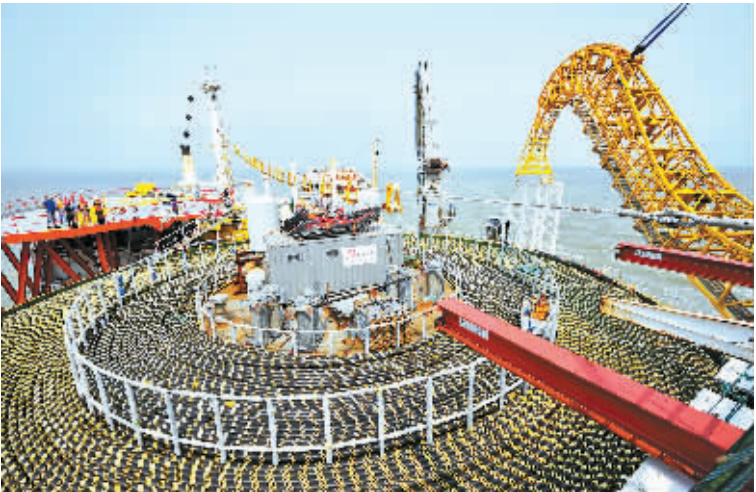
3月11日，亚洲第一、世界第二的500千伏海底电缆开始敷设，海南联网工程施工进入攻坚阶段。
