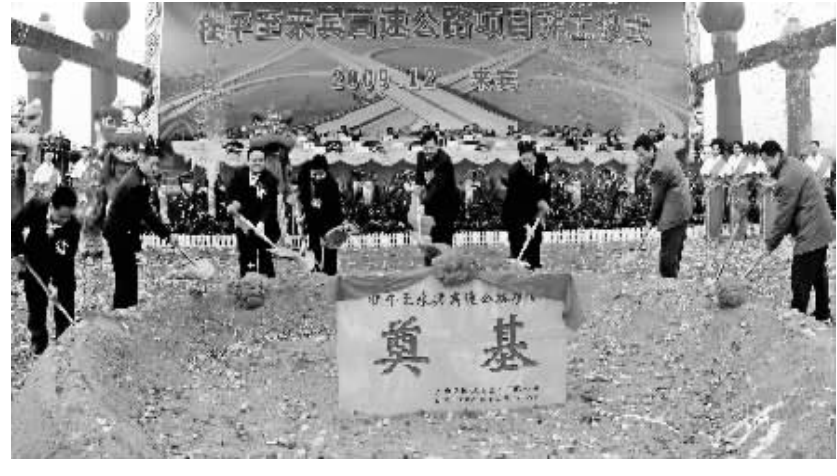
2009年12月29日，桂平至来宾高速公路项目在广西来宾举行开工奠基仪式。2009年，广西的交通建设进入了“高速时代”，尤其在高速公路建设方面，一个以广西为中心的区域性高速公路网络正在逐步成型。新华社记者 张爱林 摄
