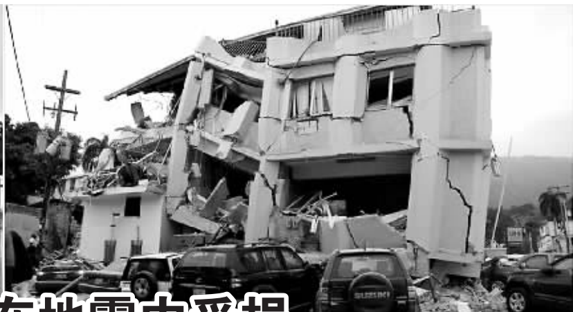
地震导致首都太子港大量建筑物严重受损或倒塌。
