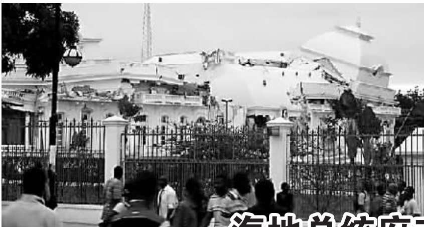
1月12日,在海地首都太子港,海地总统府在地震中受损。
