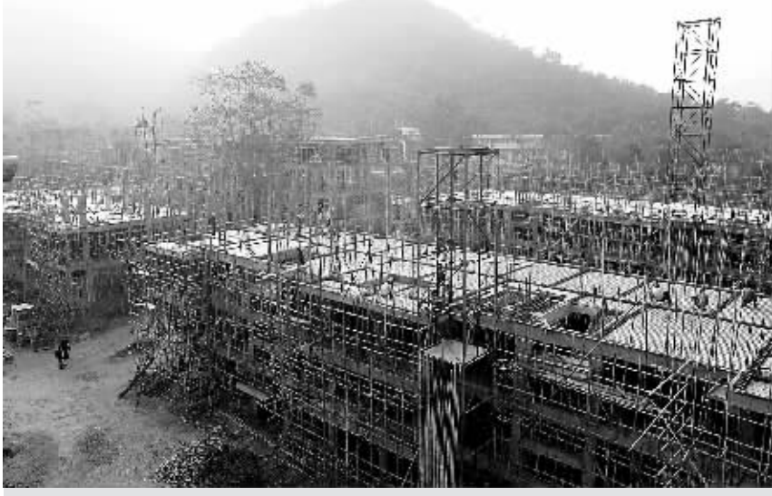
2009 年 12 月 22 日,霸王岭林业局新建的 480 套职工住房,4 个工地正在加紧施工中。预计春节前完工交付使用,将极大改善林区职工住房难问题。本报记者 苏晓杰 摄
