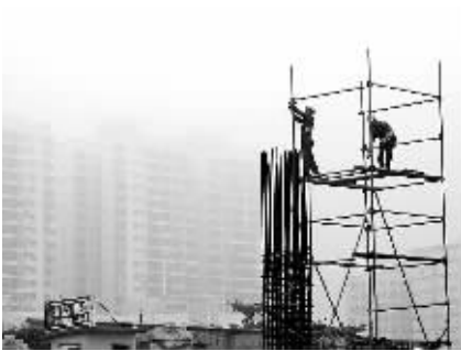
1月20日，在海口市凤翔路上，工人们正在大雾中施工，不远处的高楼掩映在大雾之中。
