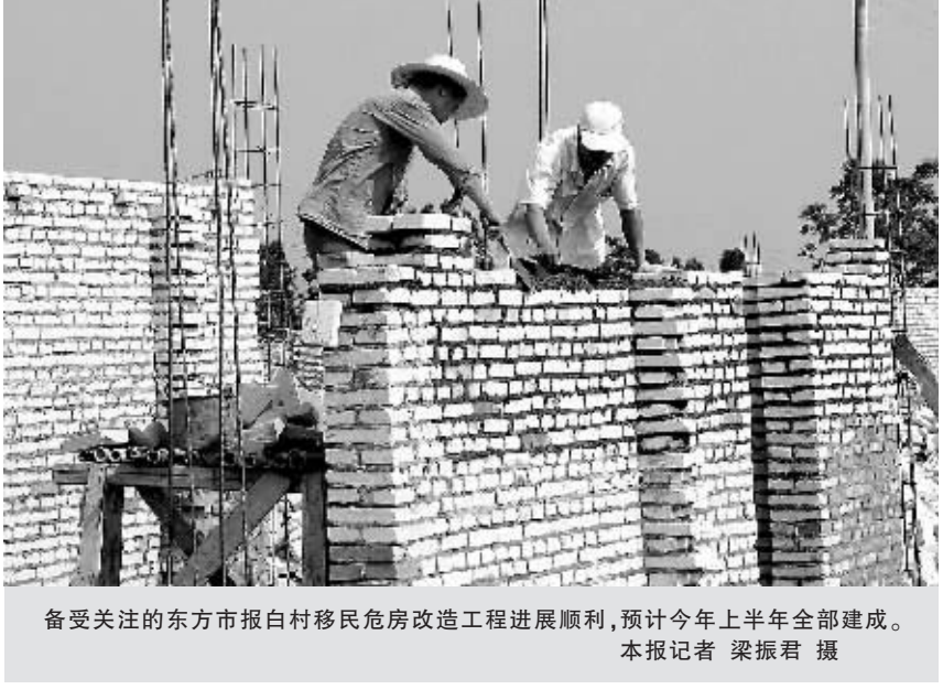
备受关注的东方市报白村移民危房改造工程进展顺利,预计今年上半年全部建成。 本报记者 梁振君 摄
