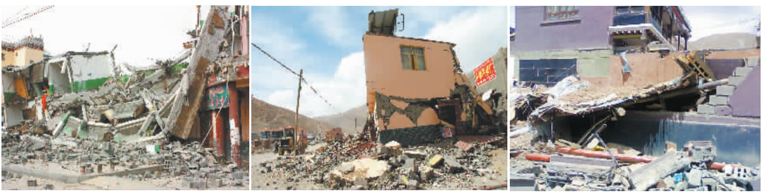
玉树州结古镇倒塌的房屋。 灾区严重受损的房屋(4月14日摄)。 结古镇地震现场。(本版照片:新华社发)
