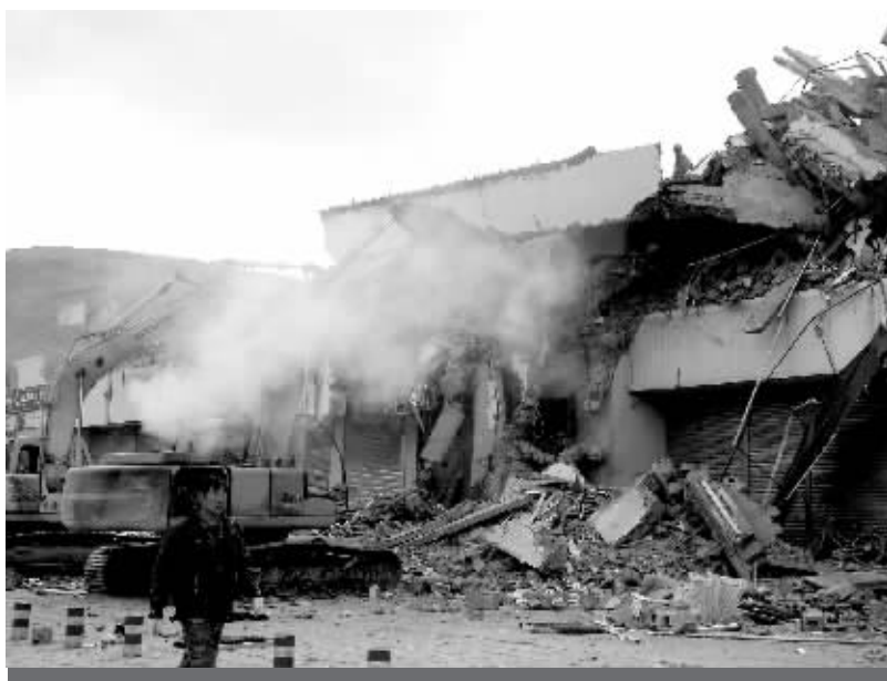
挖掘机在青海玉树地震灾区清理受损房屋的外立面。
